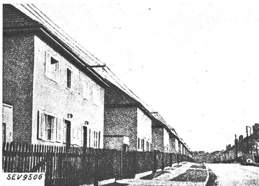
Fig. 2. An Auslegern verlegte Freileitungen.
