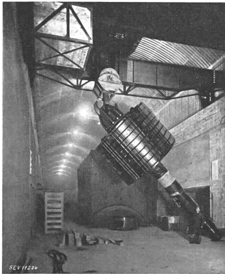
Fig. 4. Anheben des Rotors mit Welle mittels am Kupplungsflansch befestigter Aufhängevorrichtung (Vgl. Bull. SEV 1942, Nr. 20, S. 535, Fig. 13.)
