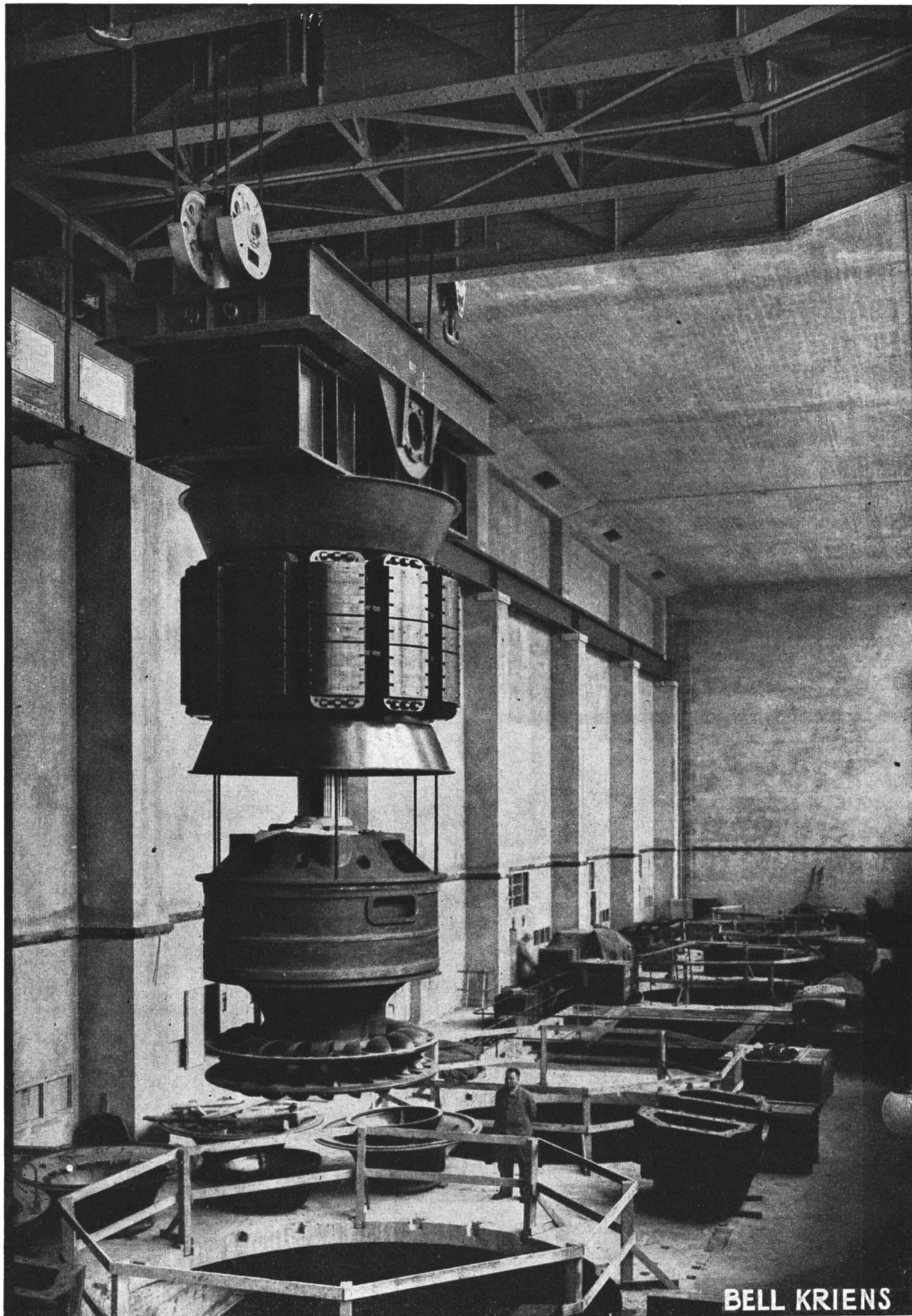
22 000-PS-Pelton-Turbine mit Rotor beim Einfahren während der Montage im Etzelwerk (Schweiz)
