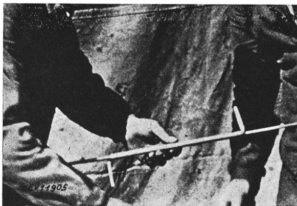
Fig. 24. Joint torsadé, prêt à la torsion
