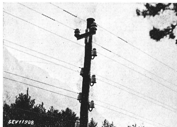
Fig. 27. Joints torsadés d'une ligne de télécommunication, dont les fils ont été croisés ultérieurement
