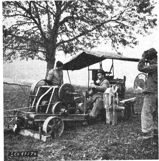
Fig. 37. Seilzugmaschine auf dem Baulos 12
