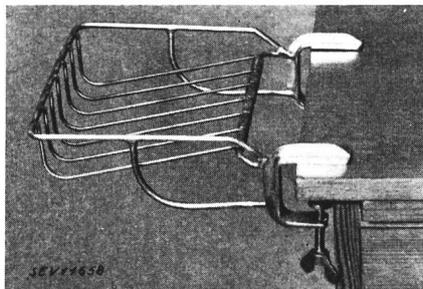
*Description:* Support pour fers à repasser de ménage, selon figure, avec dispositif pour fixation à une table. Le support se compose de fers ronds de 3,5 et 6 mm de diamètre. Surface disponible: 180 × 245 mm. Distance entre la table et le support: 40 mm.
