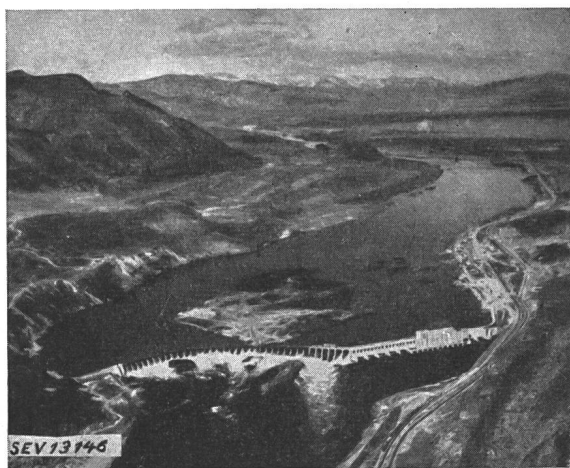
Fig. 9. Rock-Island-Kraftwerk [4 (später 10) × 16 667 kVA]
