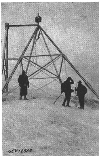
Fig. 8. Umgebautes Spezialtragwerk auf der oberen Schmelde
