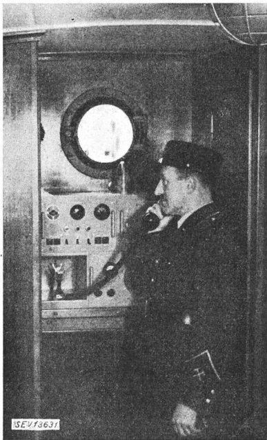
Fig. 11. FM-Funkstation in einem Löschboot der Basler Feuerwehr
