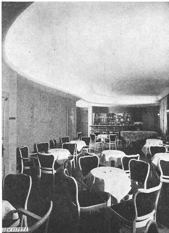
Fig. 9. Indirekte Beleuchtung einer Bar mit Hochspannungs-Fluoreszenzröhren
