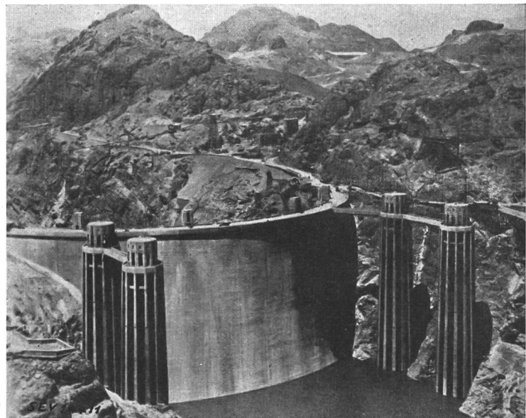
Fig. 6 Boulder Dam Staumauer von der Oberwasserseite aus gesehen, kurz nach Staubeginn
