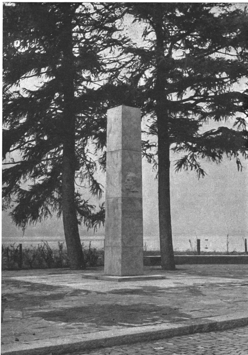
DAS DENKMAL HUBER-STOCKAR IN FLÜELEN
