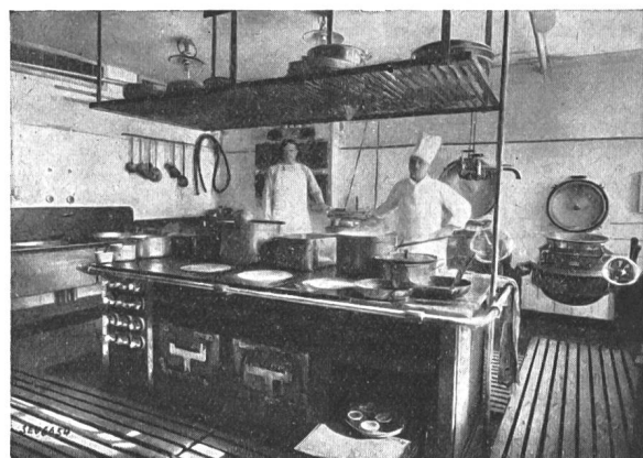
Die elektrische Küche im Berghaus
