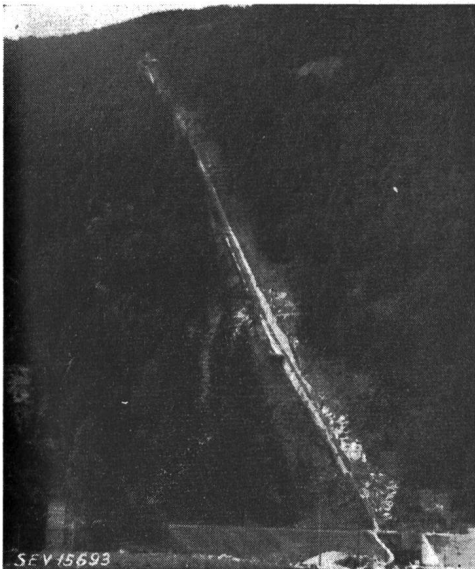
Das Tracé der Druckleitung bei Rothenbrunnen
