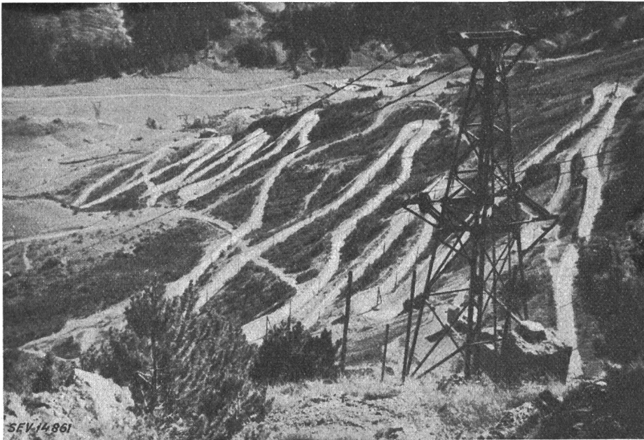
Fig. 19 Kehren mit einspuriger Trolleybus-Fahrleitung im Oberveltlin
