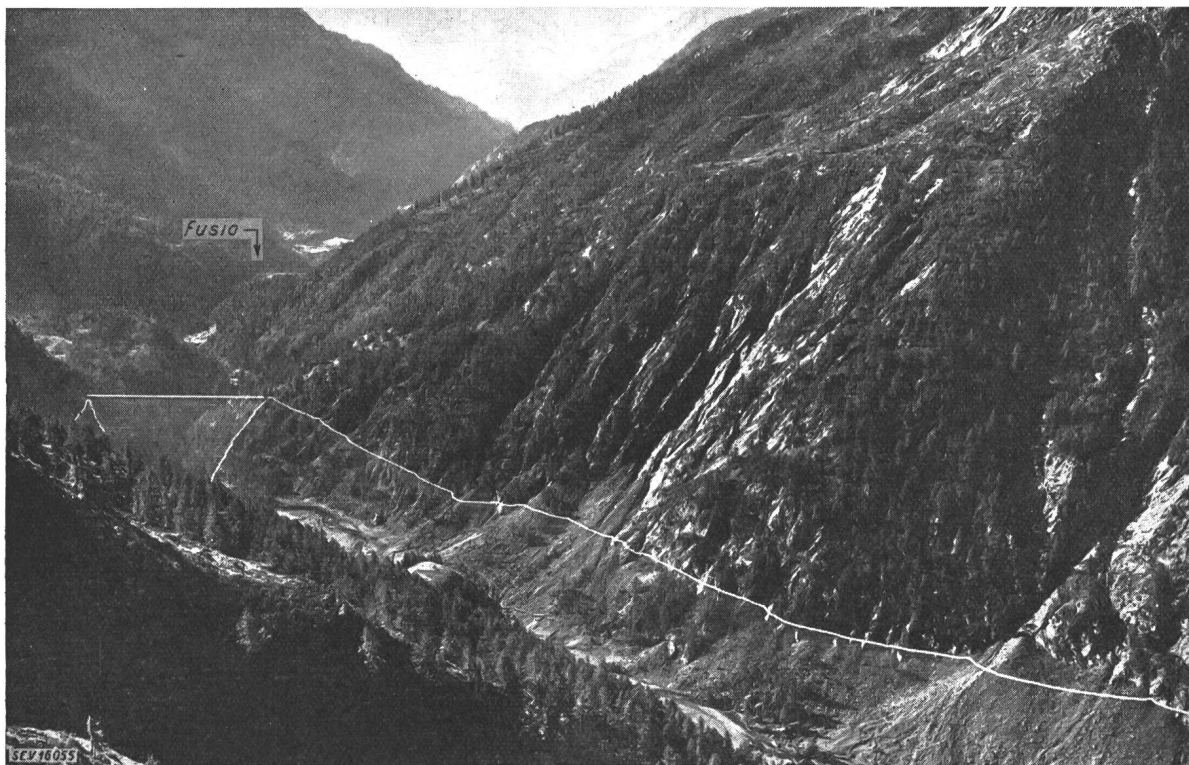
Fig. 5 Speicherbecken Sambuco, talabwärts
