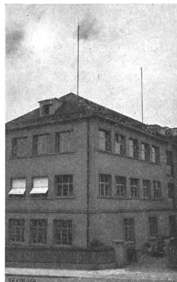
Fig. 12 Central téléphonique de Riedtli On remarque, sur le toit, les antennes d'émission et de réception
