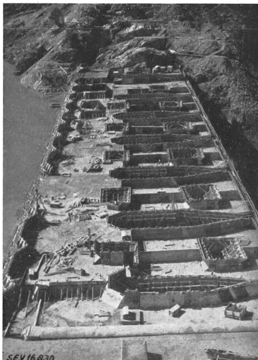
Fig. 4 Die Staumauer von Cleuson im Bau am 3. Oktober 1949
