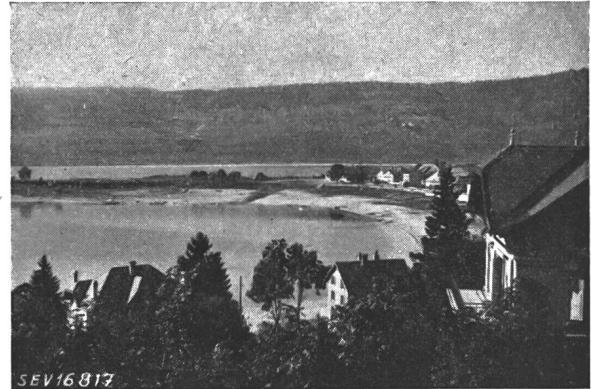
Fig. 7 Le Pont mit Lac de Joux und, im Hintergrund, Lac Brenet Der tiefe Wasserstand gibt Uferpartien frei, die Plages gleichen
