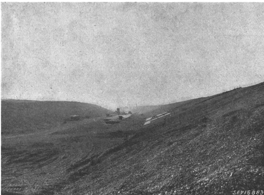
Fig. 10 Der fertig ausgehobene Kanal mit den fertig angeschütteten Uferdämmen. In Bildmitte sieht man das Einbringen der Sohlen- und Böschungsbetonplatten (vorfabrikizierte Platten)
