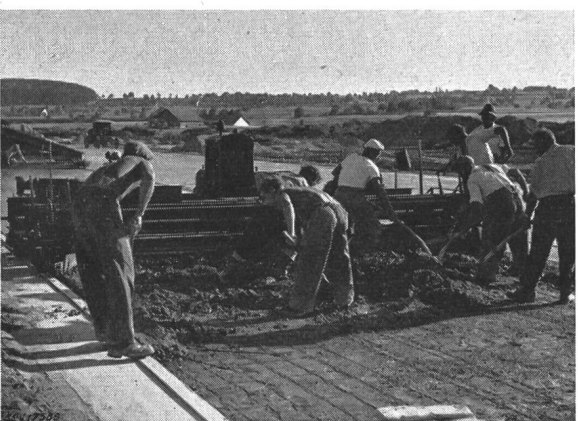
Fig. 8 Einbau des 27 cm starken Betonbelages mit dem Betonstrassen-Fertiger Im Vordergrund die Stahldrahtarmierung
