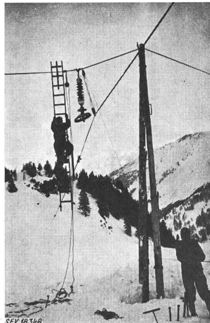
Fig. 7 Lukmanierleitung bei Acquacalda Provisorische Behebung des Unterbruches
