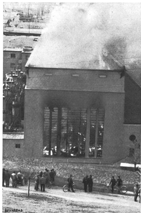
Fig. 3 Face sud de l'usine Le toit s'est effondré sur les machines et l'incendie continue sous celui-ci
