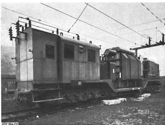
Fig. 4 Fahrbares Unterwerk der ÖBB
