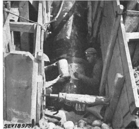
Fig. 3 Isolation d'un joint soudé de la nouvelle conduite d'eau de la Hard à Bâle (P. Pfirter, Pratteln)
