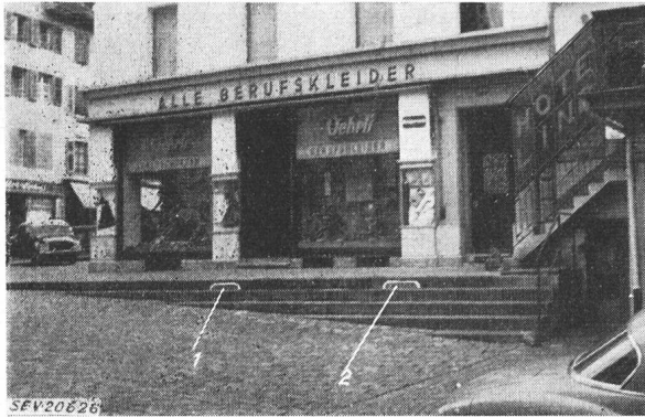
Fig. 12 Station souterraine sous un escalier 1, 2 Ouvertures de ventilation
