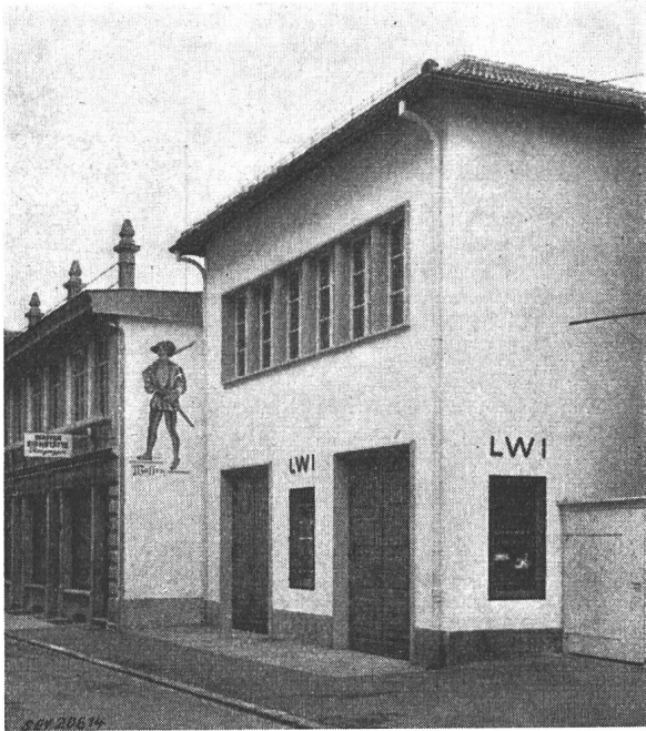
Fig. 8 Aussenansicht der Transformatorenstation
