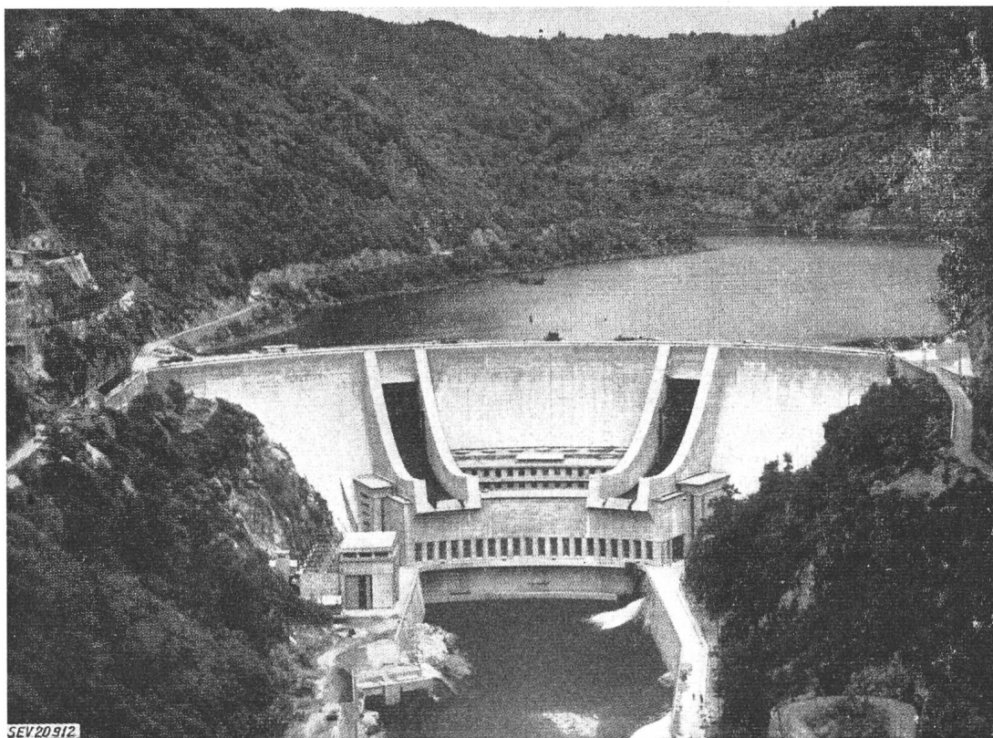
Fig. 2 Gesamtansicht des Kraftwerkes Le Chastang von der Unterwasserseite links unten: die Freiluft-Transformatorstation
