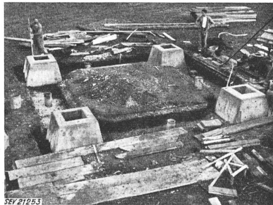
Fig. 12 Fundamentbau auf der 380-kV-Leitung Amsteg—Mettlen Rahmenfundament, Baujahr 1947
