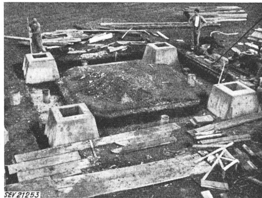
SEV21253 Fig. 12 Fundamentbau auf der 380-kV-Leitung Amsteg—Mettlen Rahmenfundament, Baujahr 1947
