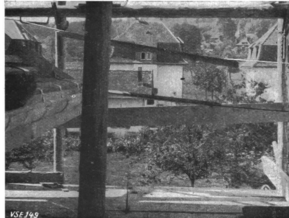
Fig. 5 Accident mortel en basse tension sur un échafaudage traversé par une ligne insuffisamment protégée Un couvreur a trouvé la mort ici. Tension en jeu: 250 V
