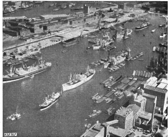
Fig. 13 Una parte del porto di Rotterdam
