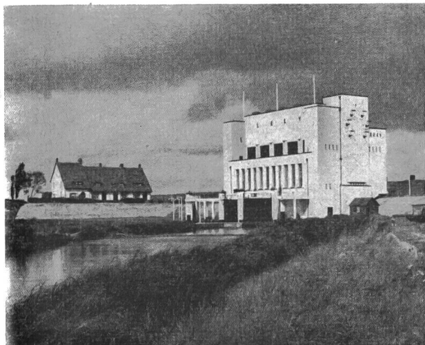
Fig. 9 L'impianto di pompaggio «Lely»
