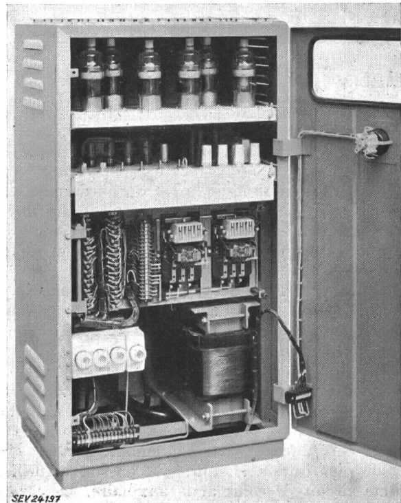
Fig. 7 Régulateur électronique Hasler-Oerlikon pour groupe Ward-Leonard, vue intérieure
