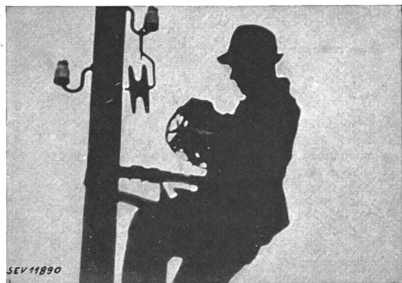
Fig. 4 Poulie de déroulage incorrecte Le diamètre de la poulie est trop petit
