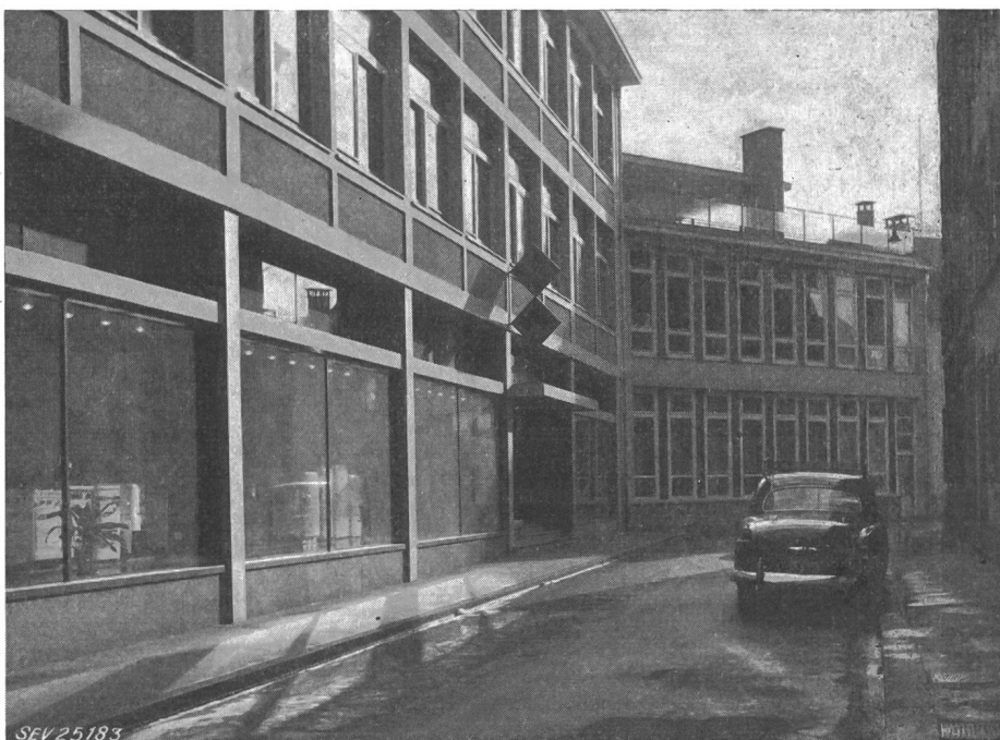
Fig. 11 Entrée de la salle à la Kohlenberggasse, avec les deux étages des écoles
