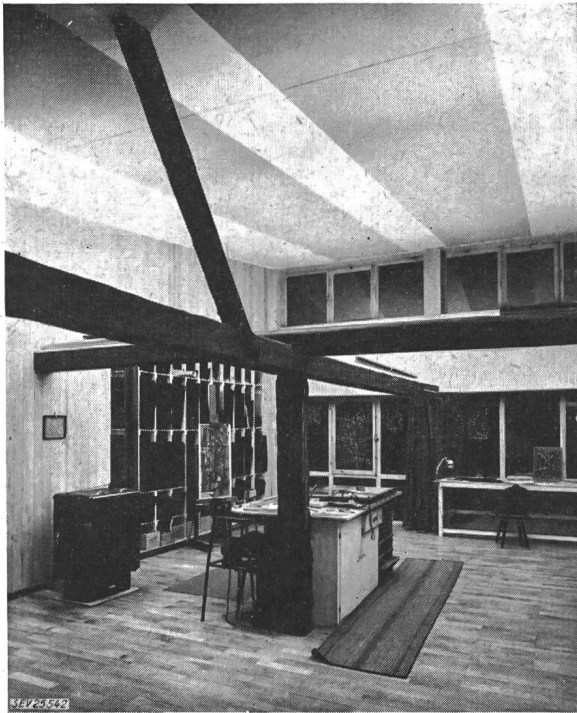
Fig. 9 Glasmaler-Atelier Rajsek in Boswil, Kt. Aargau Indirekt-Beleuchtung mit Fluoreszenzlampe, auf Balken montiert, 4 \times 40 W
