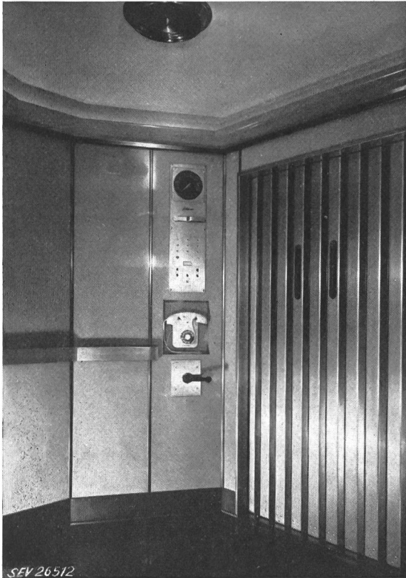
Fig. 1 Innenansicht der Kabine des «Atomium»-Aufzugs
