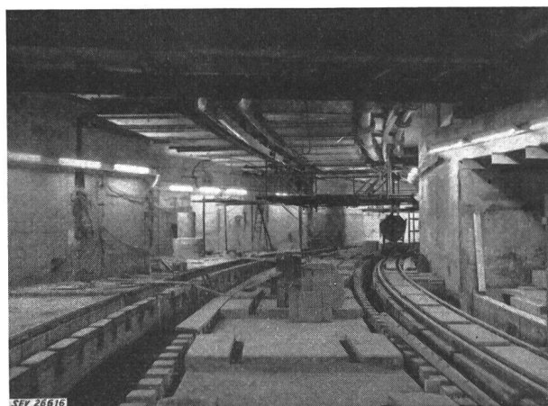
Fig. 10 Intérieur du tunnel du PS (1957)
