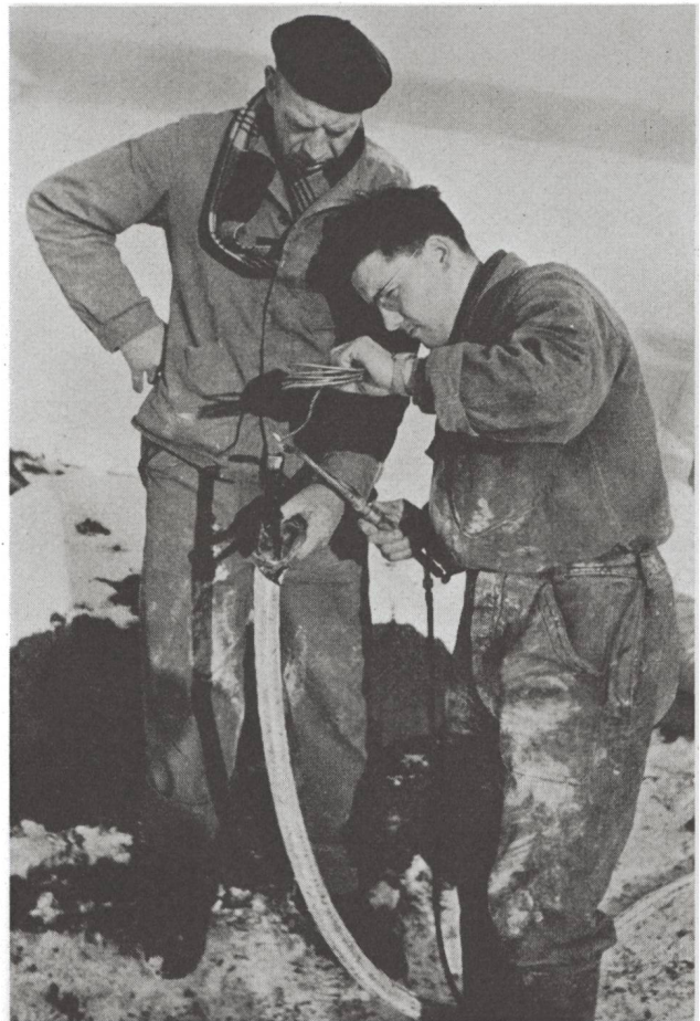
Fig. 25 Montage d'un câble
