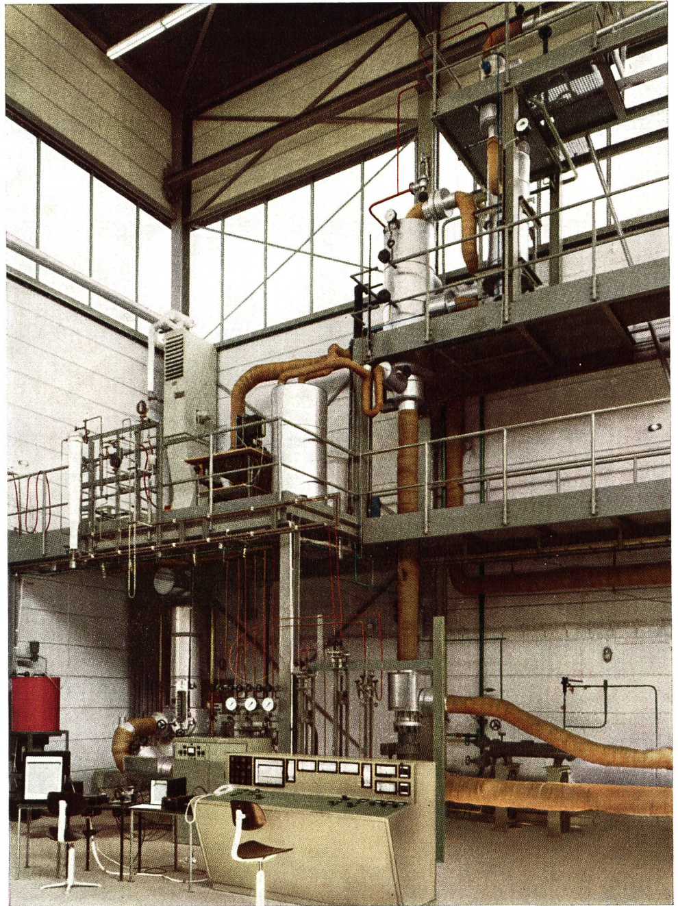
Fig. 3 Teilansicht des Wärmepfprüfstandes
