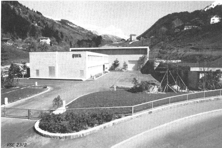
Fig. 2 Centrale de Bürklen
