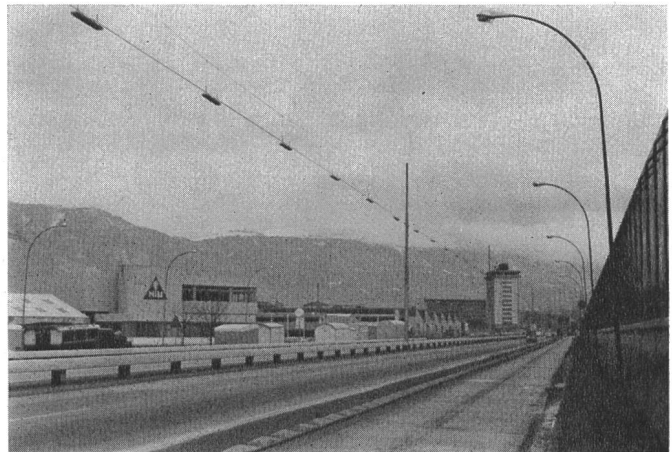
Fig. 1 Voie latérale Ouest
