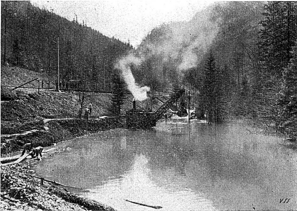
L'excavateur au travail
