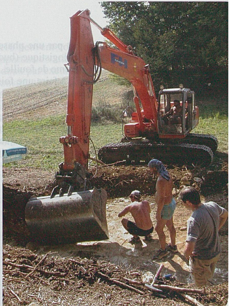
Fig. 6 : Décapage machine d'une couche marneuse à Chevenez-Combe Ronde.
