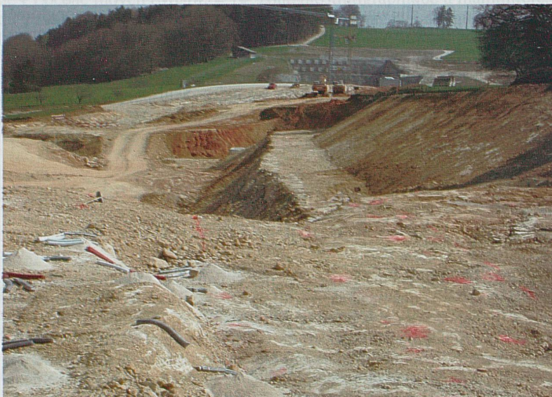
Photo 1 : Vue générale du chantier de L'Oiselier en avril 2003.
