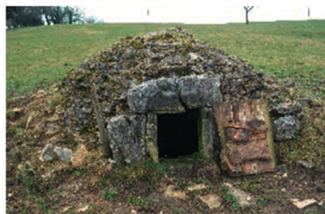
Fig. 2: Types de citernes à restaurer et à mettre sous protection patrimoniale (L. Stalder).
