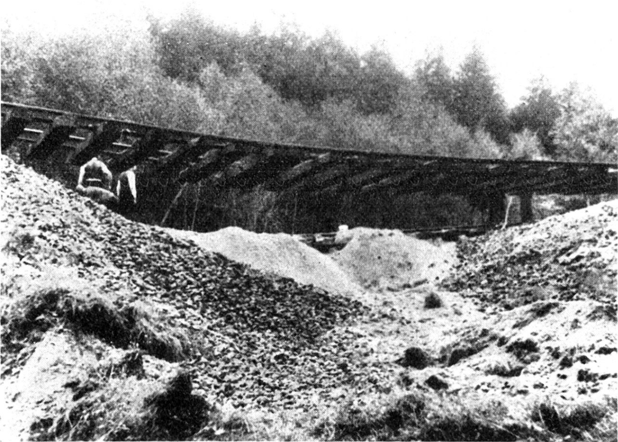
Dammsprengung zwischen Daugaard und Vejle
