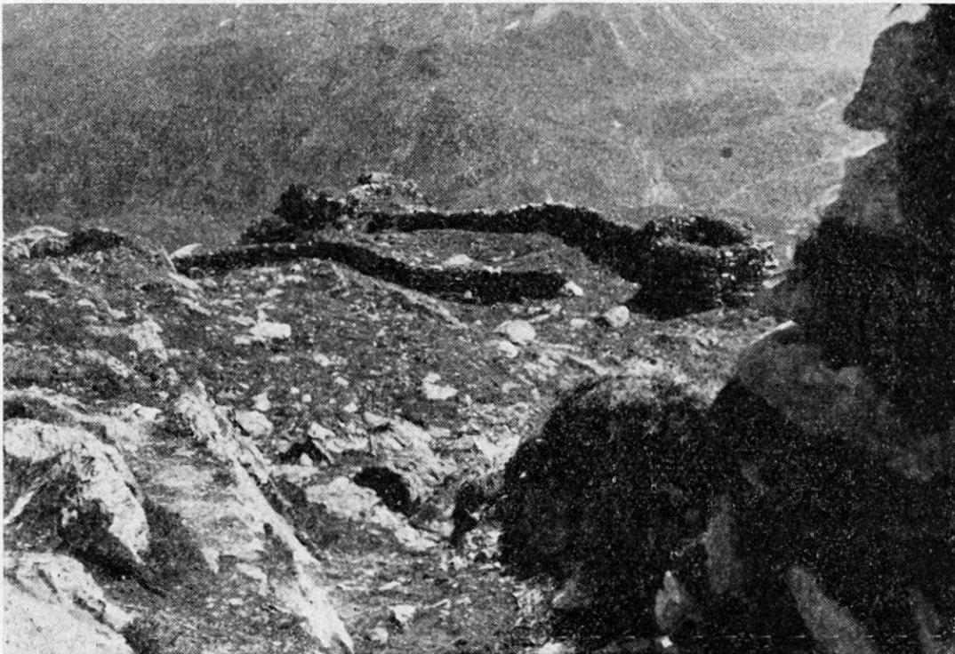
Stützpunkt, Geländeverstärkung auf Felsboden aufgebaut
