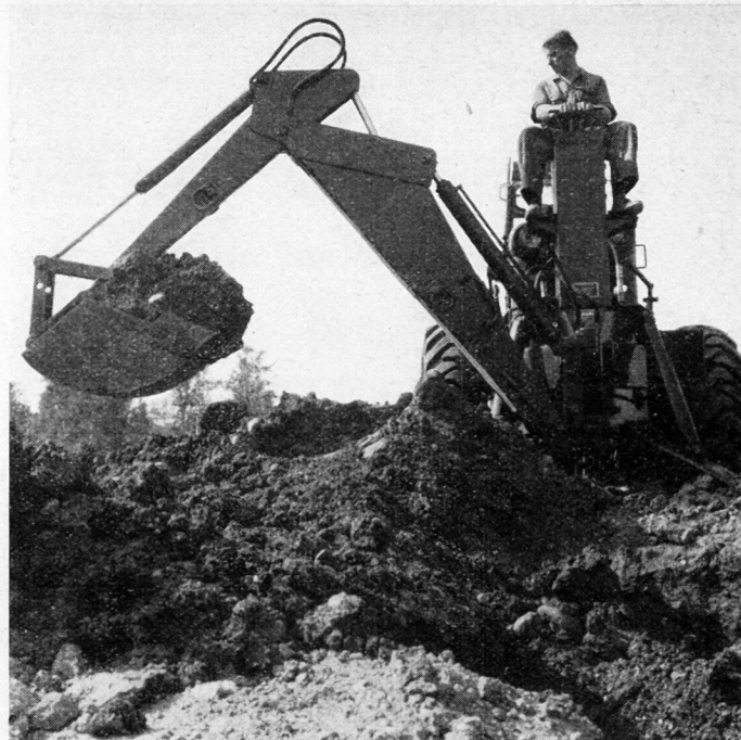
Bild 2. Tieflöffelausrüstung
