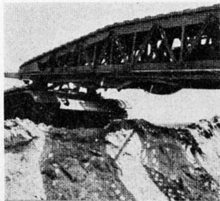
Der russische Brückenlegepanzer T-54/Br
