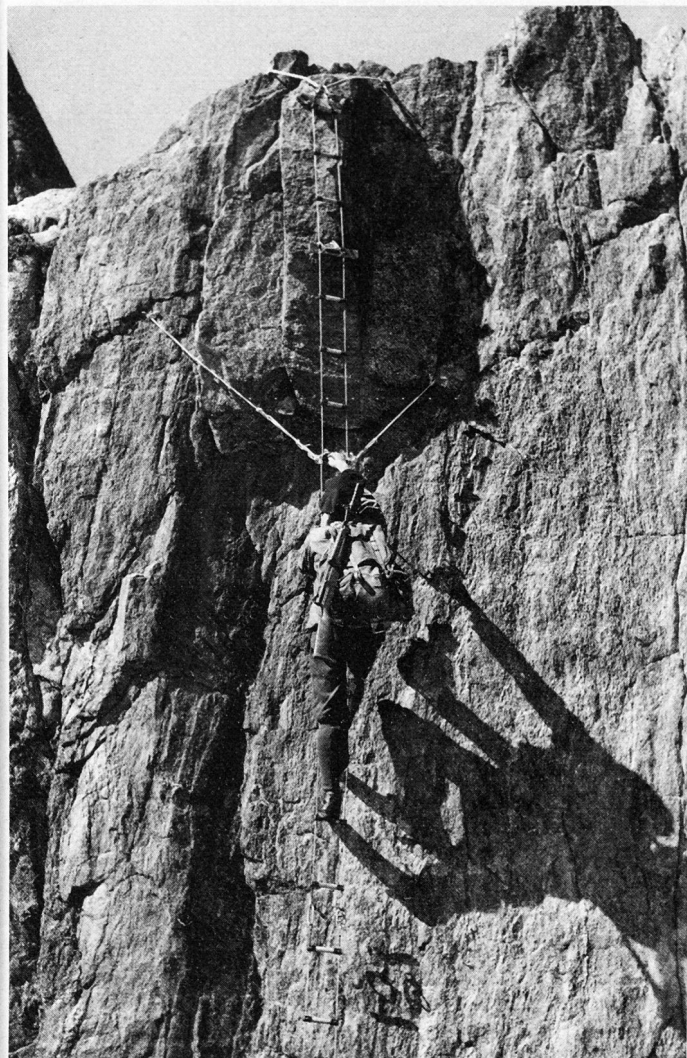
Bild 6. Von der Truppe errichtete alpine Weganlage.
